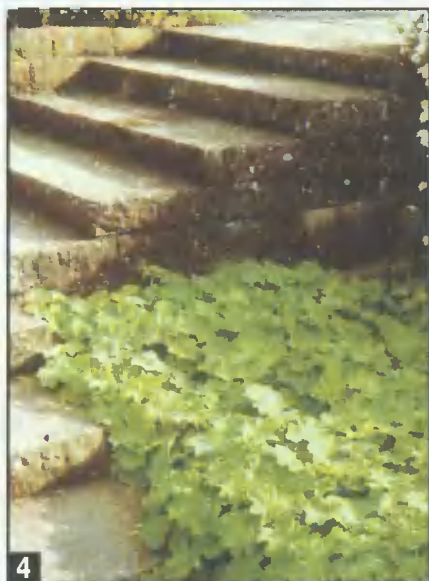
4 Ступени из бетонных или каменных плит очень удобны, однако требуют предварительного возведения морозостойкого фундамента.
