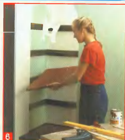
6 Остается только вставить полки в несущие профили — и практичная конструкция готова.
