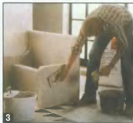
3 Поверхности скамьи шпаклюют, затем еще раз шлифуют и окрашивают.
