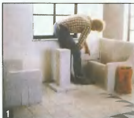
1 Кладку скамеек ведут из базовых блоков высотой 25 см и толщиной 7,5 см. Подлокотники делают и со стороны стены.
