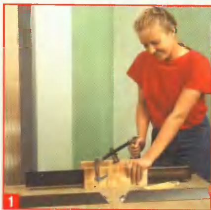
1 Со стороны угла несущие профили запиливают «на ус», что позволит потом плотно подогнать их друг к другу.
