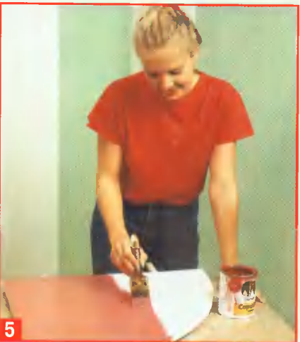
5 Когда грунтовка полностью высохнет, поверхность полки покрывают лаком.
