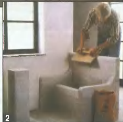
2 Закругления по краям спинок формируют с помощью терки и крупнозернистой шлифовальной шкурки.
