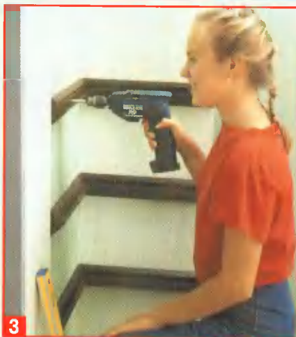
3 Приложенные к стене несущие профили тщательно выверяют и после разметки сверлят в них отверстия под дюбели.
